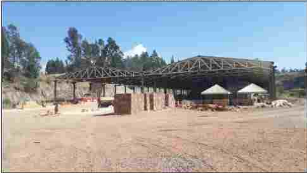
Vista general del lote de terreno Villa Aurora Cecilia # 5
