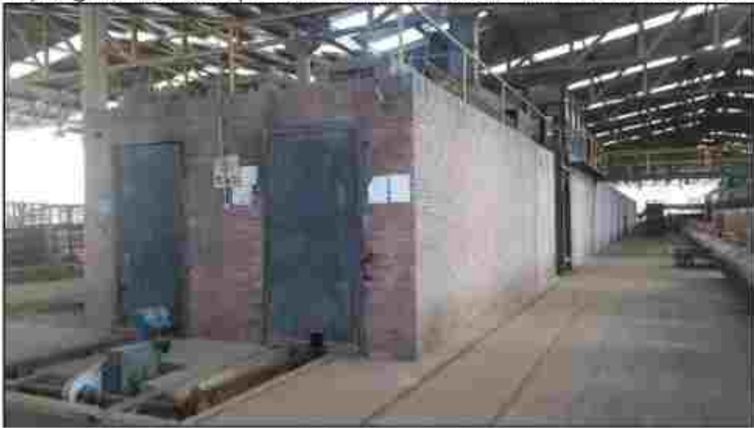
Tipología constructiva presente en lote de terreno Villa Aurora Cecilia # 4
