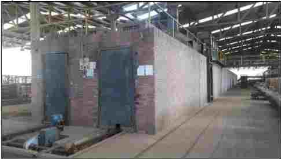
Tipología constructiva presente en lote de terreno Villa Aurora Cecilia # 3
