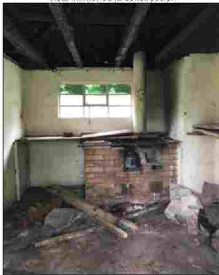
Vista interior de la construcción
